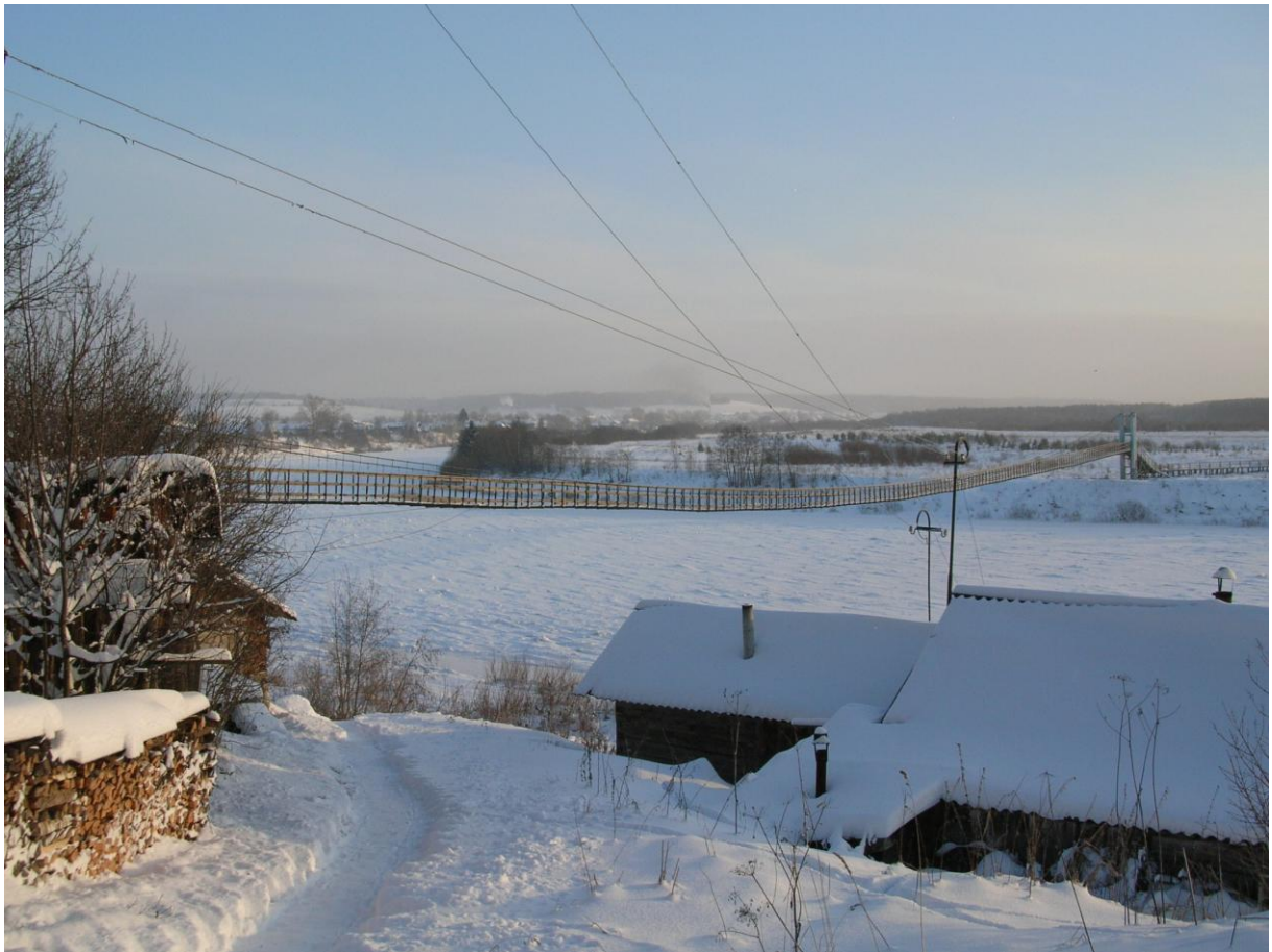
Подвесной мост через р. Устья
